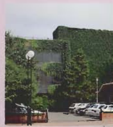
株式会社清野建設／中央区北3条東5丁目
